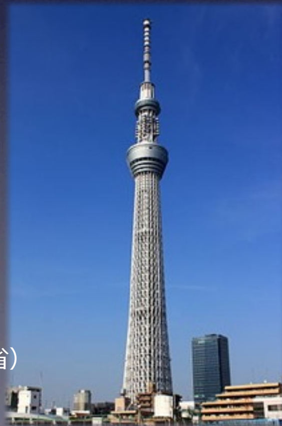
東京スカイツリー (建設中)
