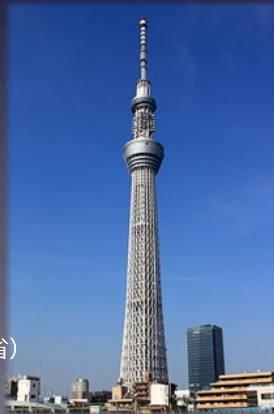
東京スカイツリー (建設中)
