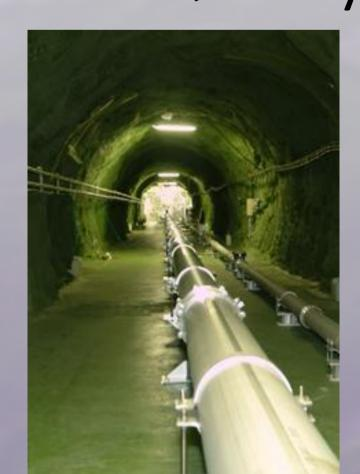
2点間の距離が長ければ長い程、重力波による距離変動も大きくなります。そこで3kmという長距離にわたってFabry-Perot干渉計を構築し、信号を増幅します。
